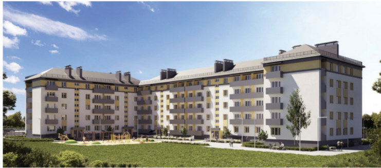
Капітальний ремонт багатоквартирного житлового будинку в м. Ірпінь, Бучанський район, Київської області по вул. Миру 1а, який постраждав внаслідок військової агресії Російської Федерації проти України (в т.ч. проектування)
